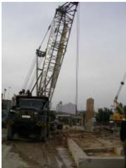
ポンプ場建設地での工事の様子
