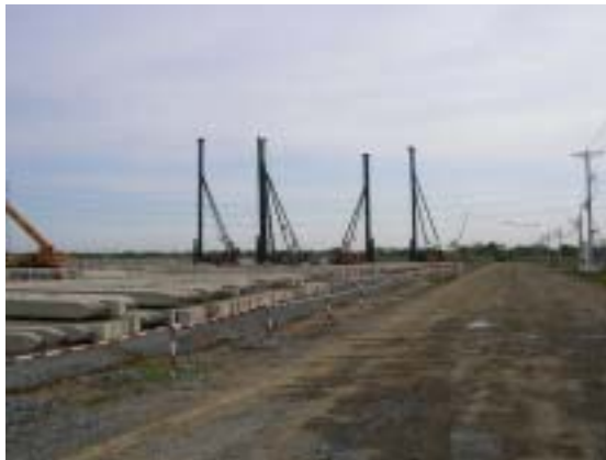
下水処理場建設工事現場
