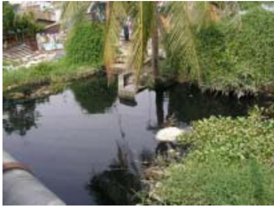
ベンメコック排水ポンプ場建設地
