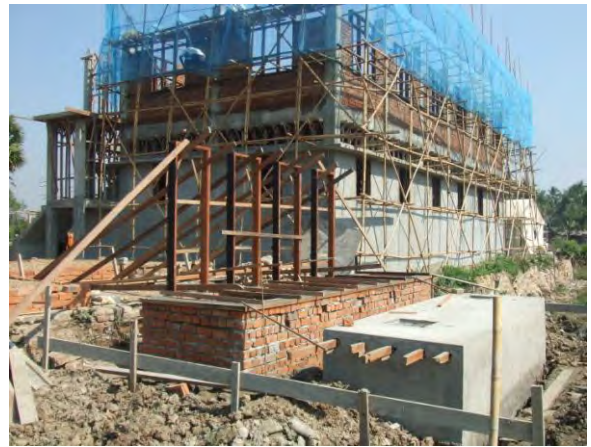
建設中のトイレ
