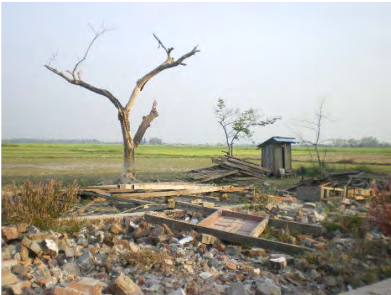
サイクロンで全壊したミェッタリンゴン高校校舎
