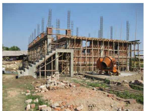
イエートウインゴン中学校校舎 50%完了時
