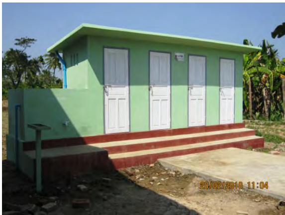
セインパン中学校の新しいトイレ
