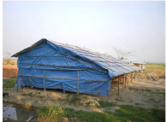
ミェッタリンゴン高校の仮設校舎
