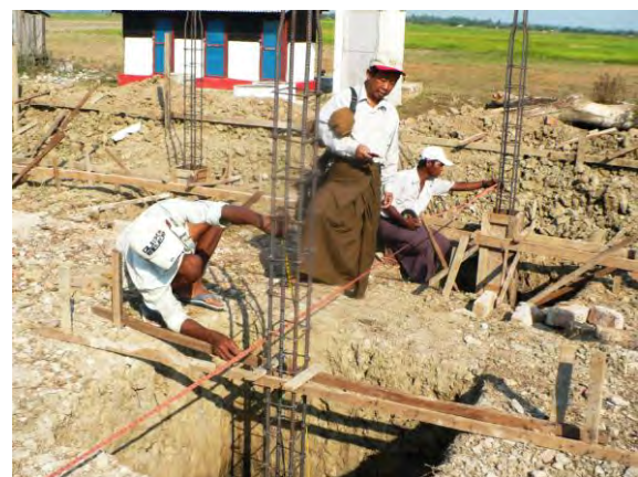
ミェッタリンゴン高校校舎の基礎工事
