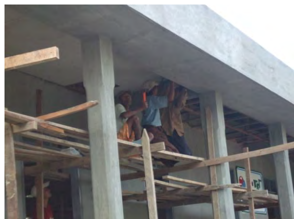
セインパン中学校校舎廊下天井部分作業
