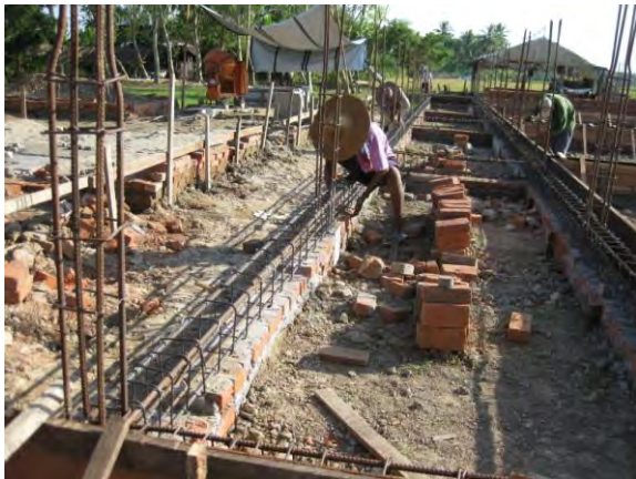
セインパン中学校校舎基礎梁鉄筋作業
