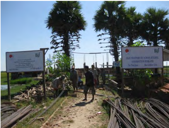
イエートウインゴン中学校校舎建設地前景
