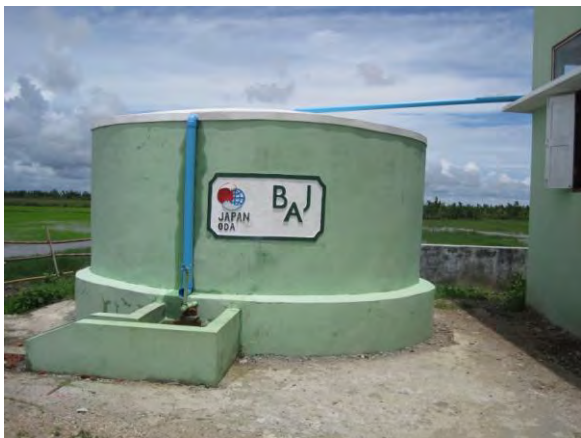
イエートウインゴン中学校の雨水収集タンク
