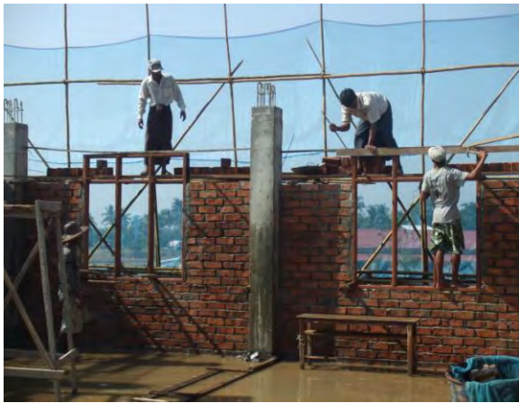
イエートウインゴン中学校校舎 2階壁面工事
