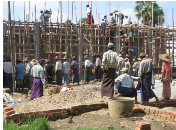
セインパン中学校校舎前面作業風景
