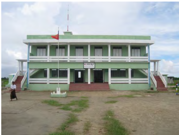
イエートウインゴン中学校で完成した新校舎
