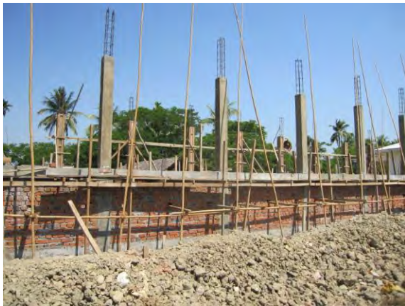
ミェッタリンゴン高校校舎建設現場(2010年4月)
