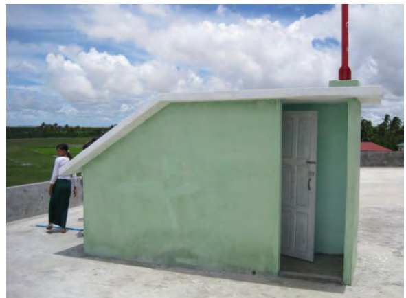
高潮・洪水の際には校舎の屋上に避難できる
