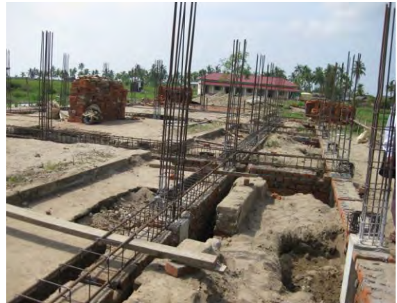
イエートウインゴン中学校校舎基礎梁
