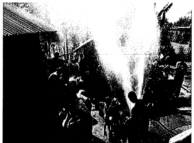
高圧の空気を送って井戸孔を洗浄（3時間）、途中、水を汲みに来る村落住民たち
