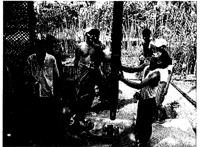
さび止めを塗布したエレメント・パイプを設置
