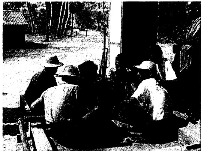
ポンプ・揚水管引き上げ作業開始 この井戸は、僧侶が管理している
