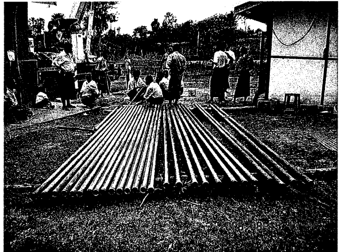
揚水管はサビ止めのため塗料をぬる
