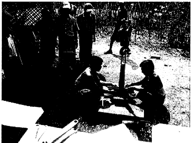
ポンプ・パイプ引き上げ開始
