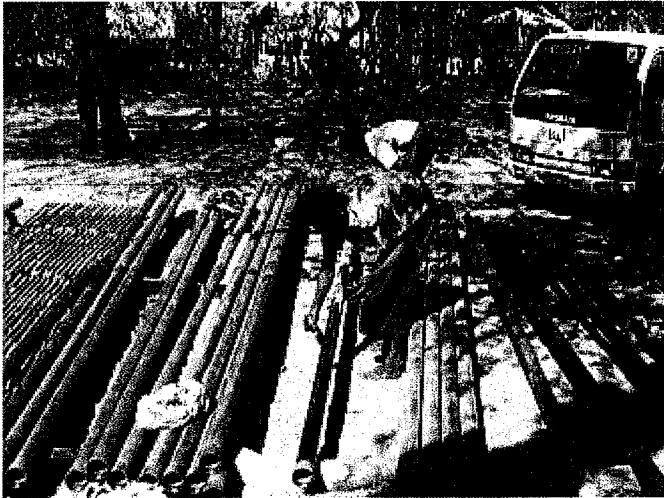
その他の揚水管にもさびどめを塗布
