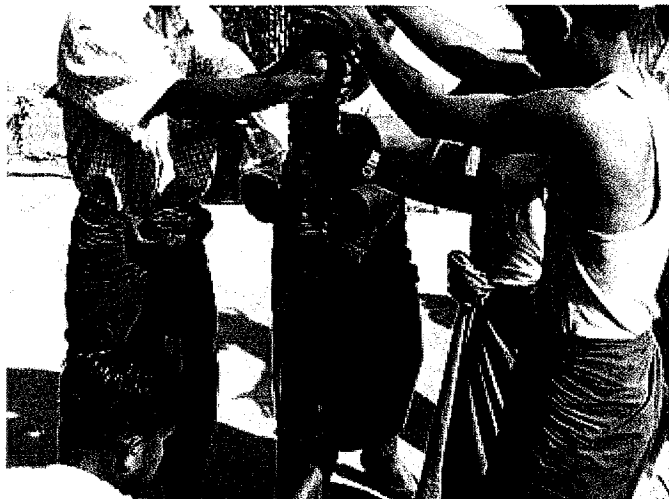
ポンプ・パイプ式の引き上げ
