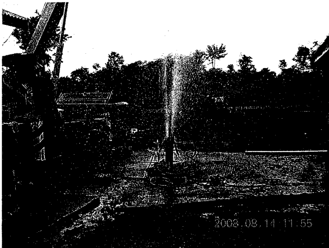
高圧の空気を送り井戸孔の掃除 (2時間 25分)
