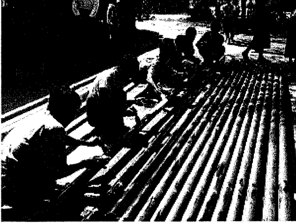
村落住民の参加により揚水管にさび止めを塗布
