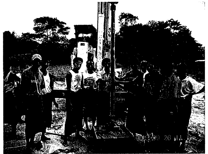
オーストラリア製モノポンプの設置
