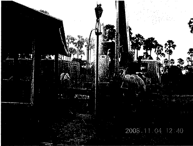
高圧の空気を送り込み井戸孔の掃除（2時間）
