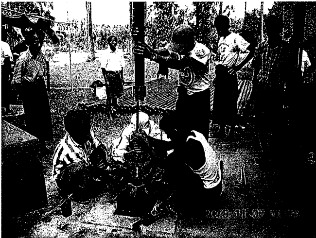
サビ止めの塗料を塗りポンプと揚水管一式を再設置 作業後の揚水量測定
