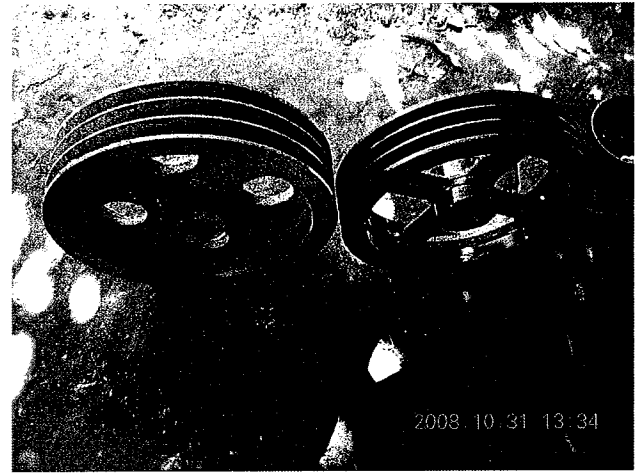
モノポンプヘッドプリーの交換
