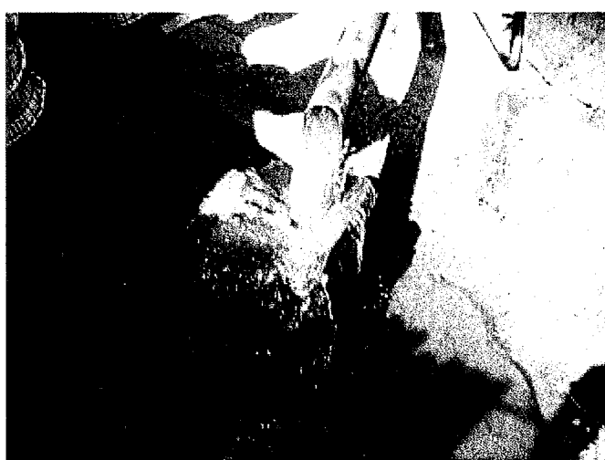
作業後の揚水量測定 作業前：毎時0ガロン→毎時2,000ガロン（150ℓ/分）
