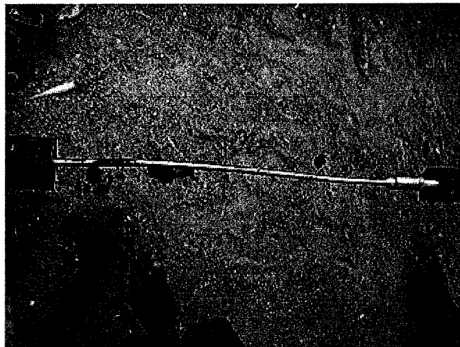
1年前に行われた修繕作業中にパイプが落下し、そのまま放置されていた井戸の修繕に着手 2日間かけて、470フィートの揚水管のフィッシングに成功
