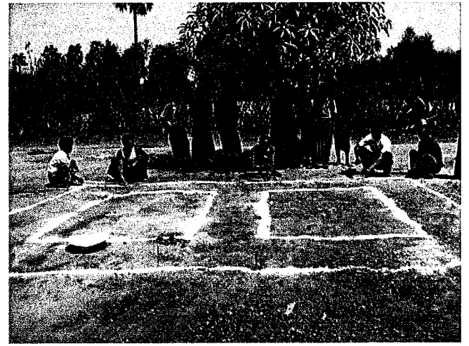
貯水タンク建設開始
