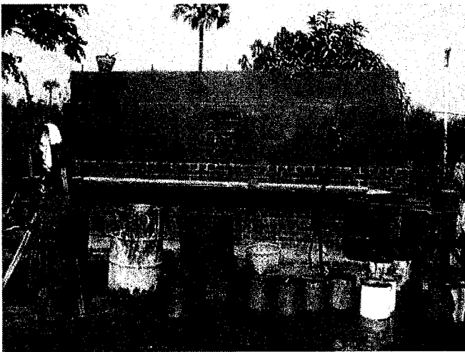
貯水タンク建設
