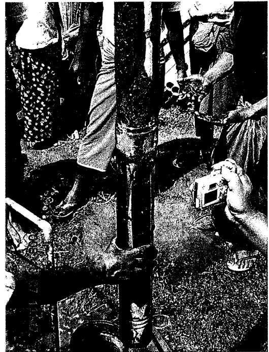
揚水管 3 本の腐食がひどい、水中ポンプも堆積物がこびりついている
