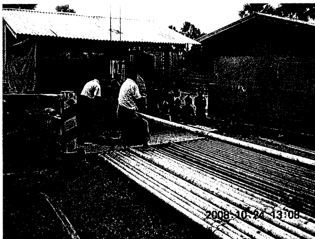
30本分（300フィート）の揚水管を交換
