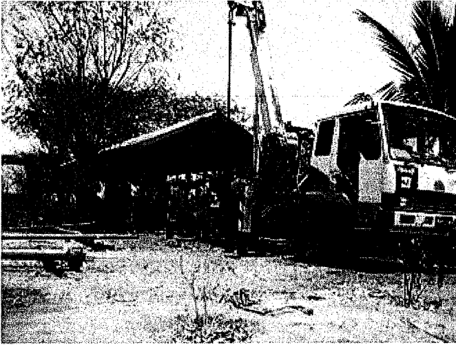
クレーン車にてパイプを引き上げている途中にクレーン車のワイヤーが破損。ステイターと12本の揚水管が井戸孔底に落下。
