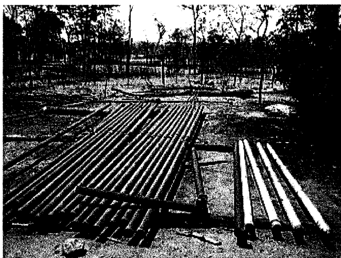
新品の揚水管4本を交換し、ポンプ・揚水管の設置
