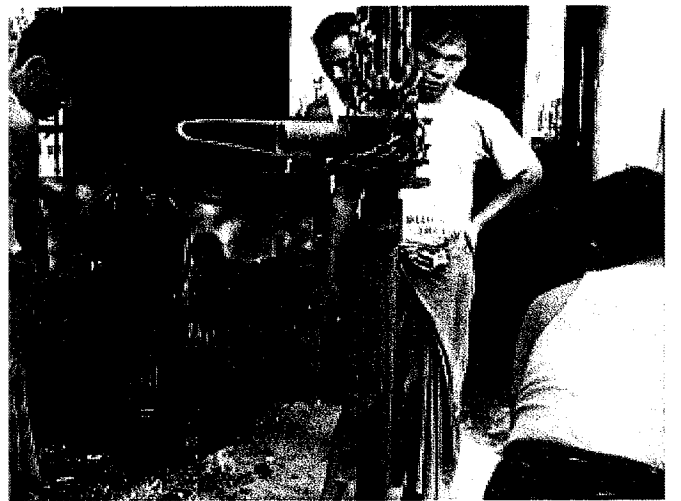
ポンプ・揚水管の引き上げ
