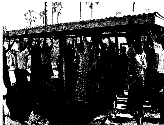
村落住民の手によりエンジンハウスの屋根がはずされる
