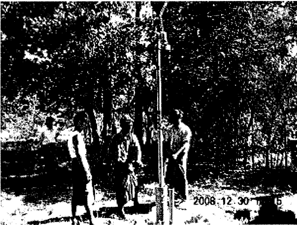
水中ポンプ・揚水管一式をひきあげ
