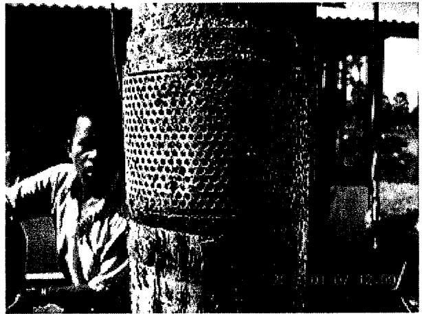
水中ポンプの取水部分に堆積物が付着
