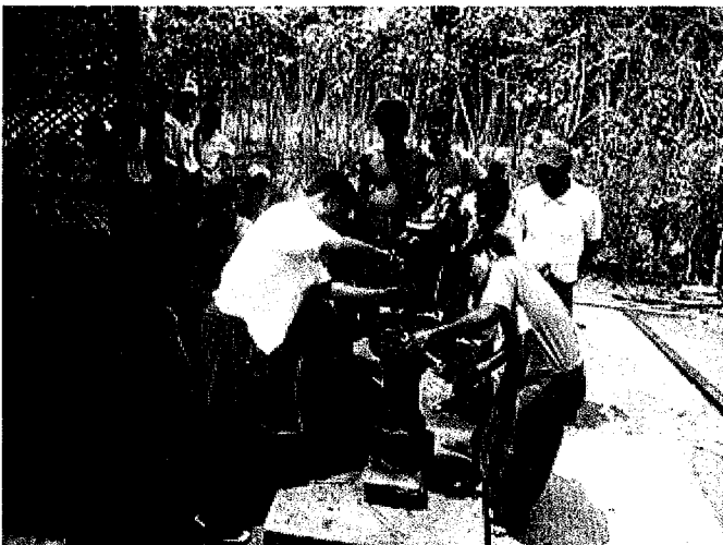
ポンプヘッドの設置
