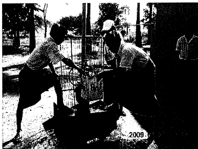
作業前の揚水量計測：毎時 1,300ガロン（97.5ℓ/分）
