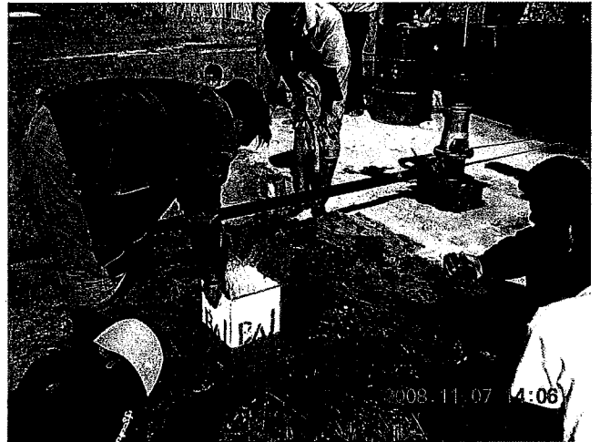
サビ止めの塗料を塗りポンプと揚水管一式を再設置 作業後の揚水量測定
