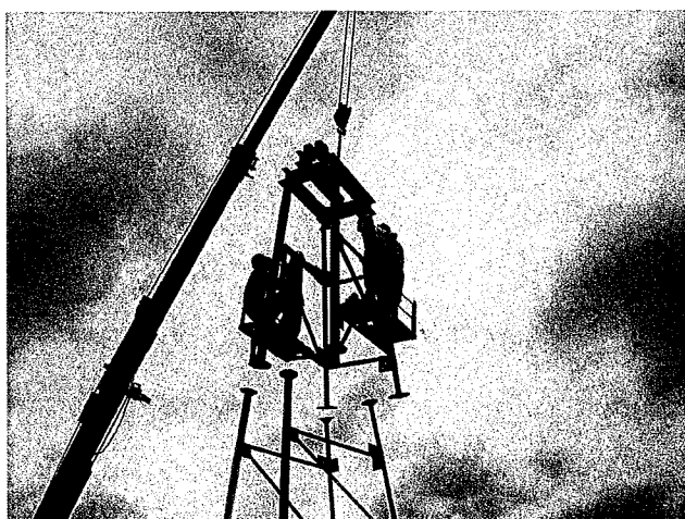
クレーンによるやぐらの設置
