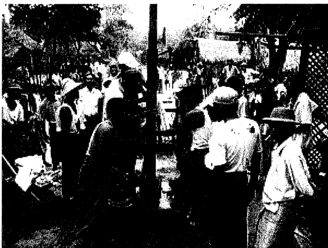
パイプ引き上げ
