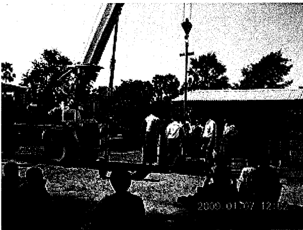
水中ポンプ・揚水管一式の引き上げ
