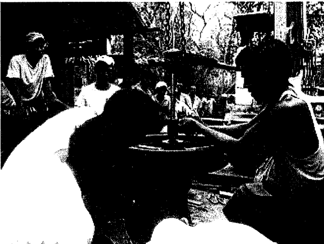
ポンプヘッドの設置
