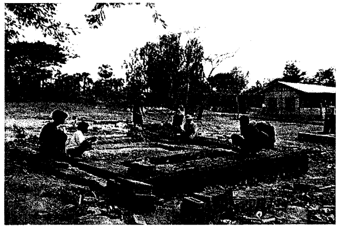
貯水タンクの建設
