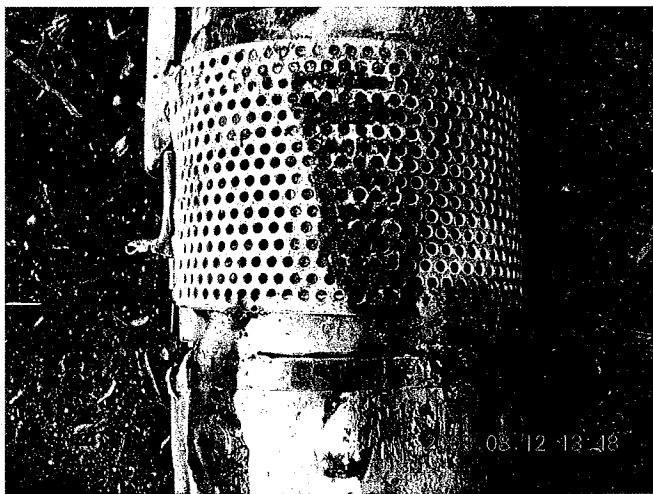
取水部分の一部が腐食
