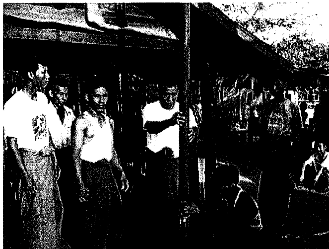
ポンプの位置を50f上げて設置
