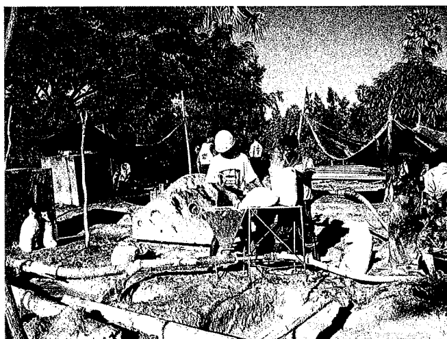
泥粉を流し、泥水濃度を調整する
