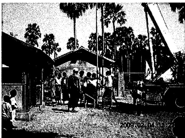
ポンプ・パイプ一式をクレーン車にて引き上げ
