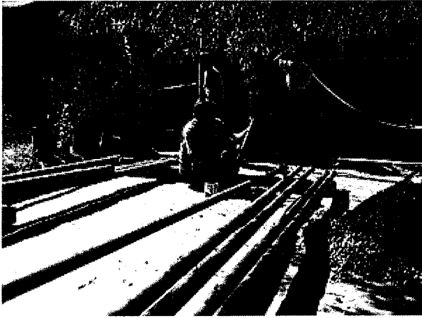
揚水管にサビ止めを塗布。揚水水位が下がったので 発電機のマイナー修理 揚水管4本を追加
