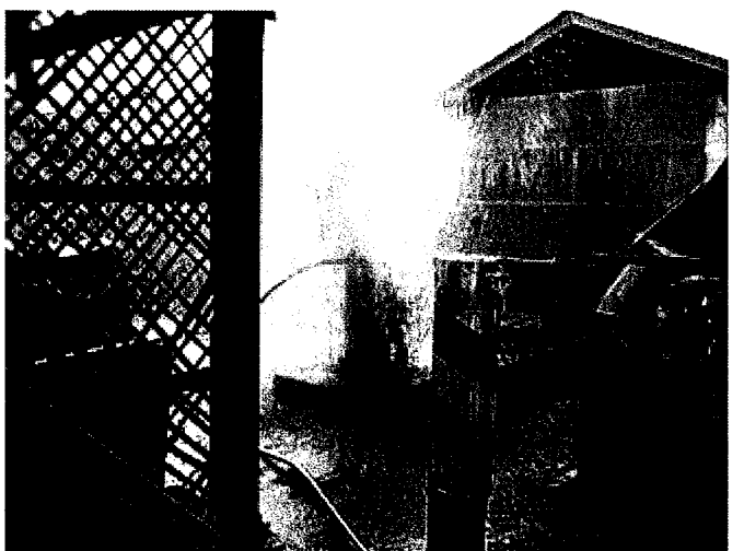
高圧の空気を送って井戸孔の洗浄（2時間）
