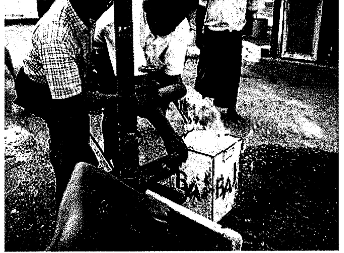
作業後の揚水量測定
