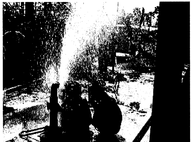
高圧の空気を井戸孔に送り込み井戸孔洗浄
