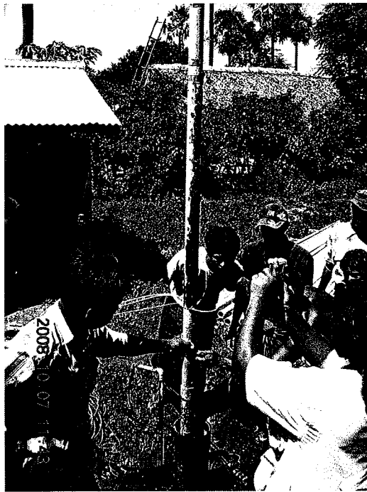
揚水管 3 本の腐食がひどい、水中ポンプも堆積物がこびりついている
