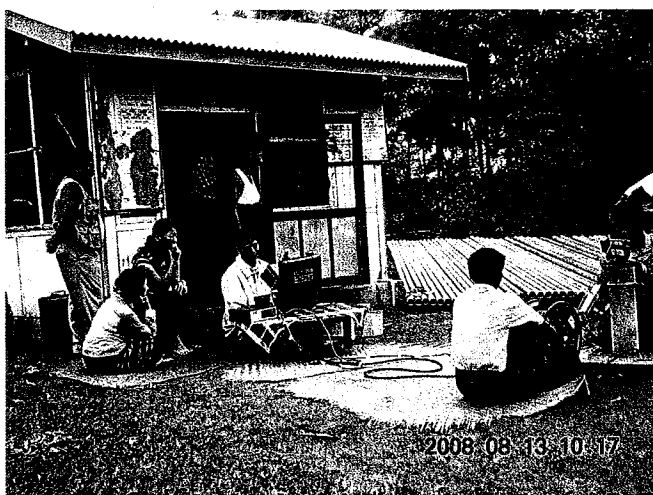
ボラホールカメラにて井戸孔診断
