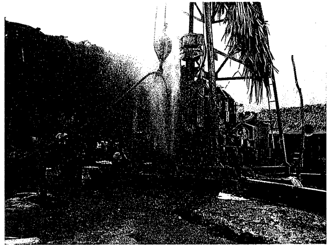
空気圧を送るデベロッピングを行い井戸孔洗浄を行う
