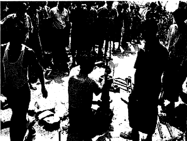
ポンプ・揚水管一式引上げ作業
