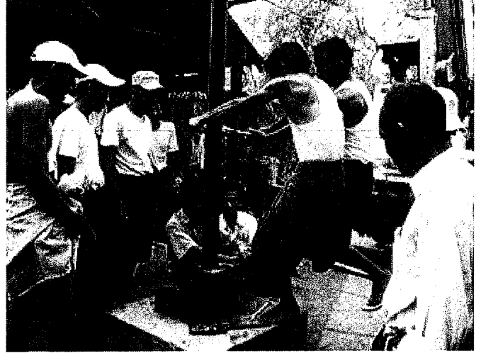
ポンプ・揚水管を設置
