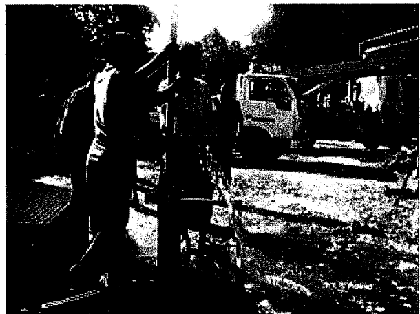
作業後の揚水量測定 作業前：毎時 1,440 ガロン (1080/分) → 毎時 2,000 ガロン (1500/分)
