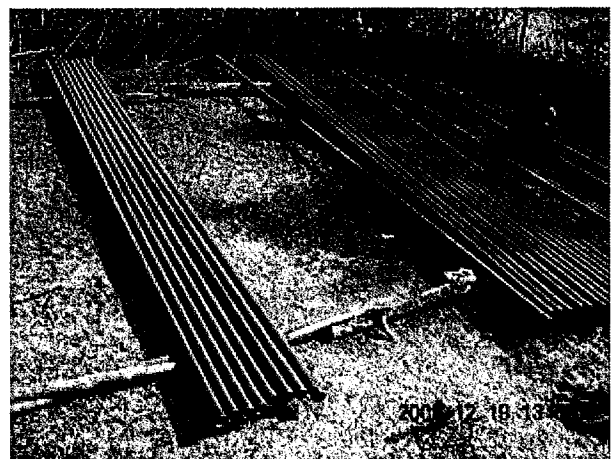
揚水管の状態は良好だったがサビ止めを塗布
