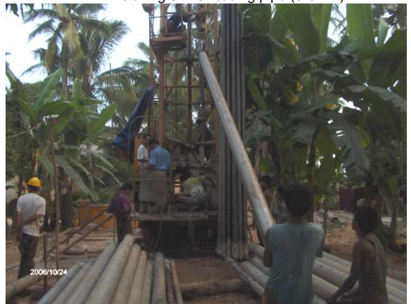
Installing 6" ø GI casing pipe (0-677ft)
