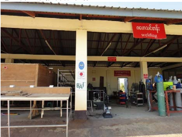
電気科・溶接科作業場
