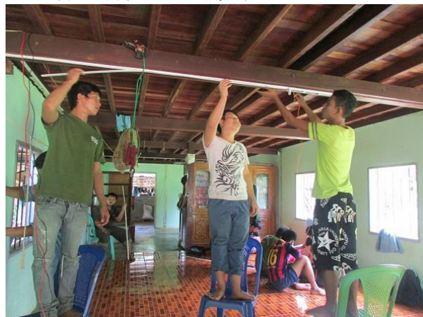
電気科 外部電気工事現場での OJT
