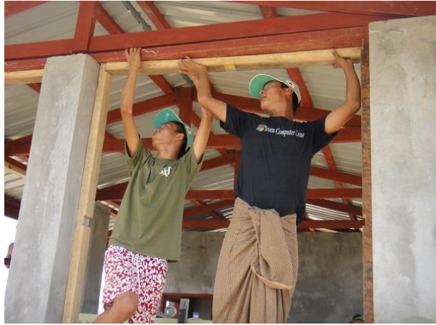
建設科 OJT (発電機建屋の建設)
