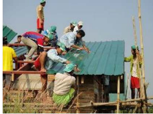
オンザジョブトレーニング (屋根設置)
