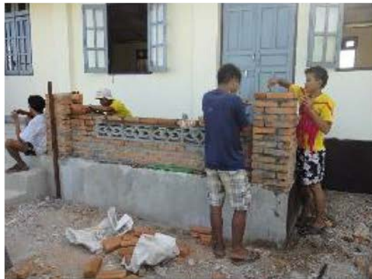
オンザジョブトレーニング (レンガ壁・柱作業)
