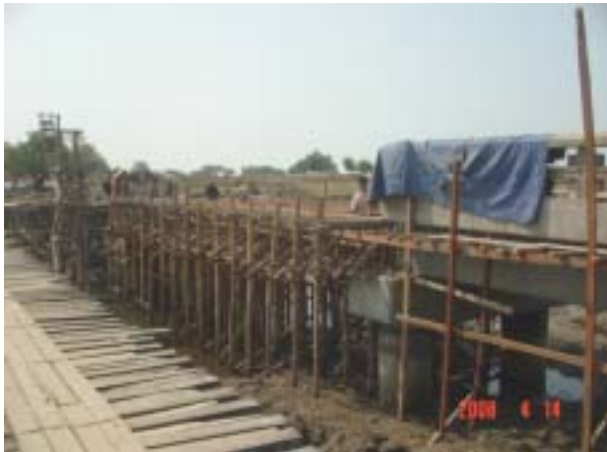
第1橋脚、第2橋脚木材型枠作業(4月14日)
