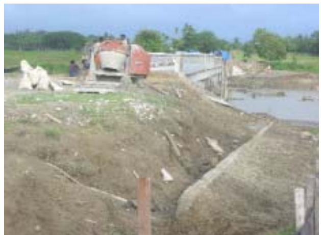
橋梁とアプローチ道路、路肩補強工事(7月31日)
