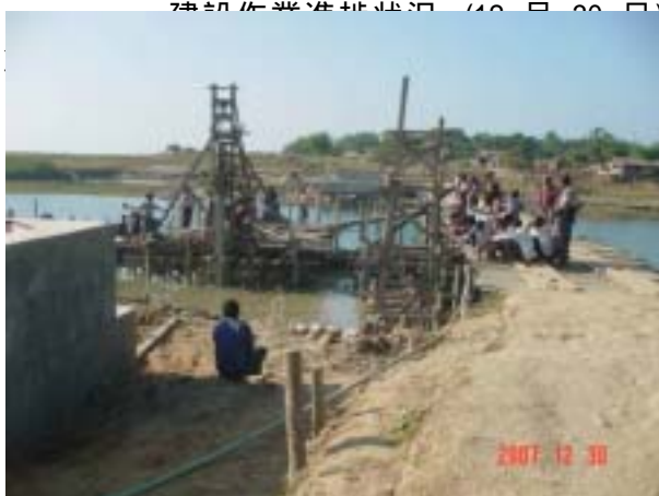
建設作業進捗状況 (12 月 30 日)
