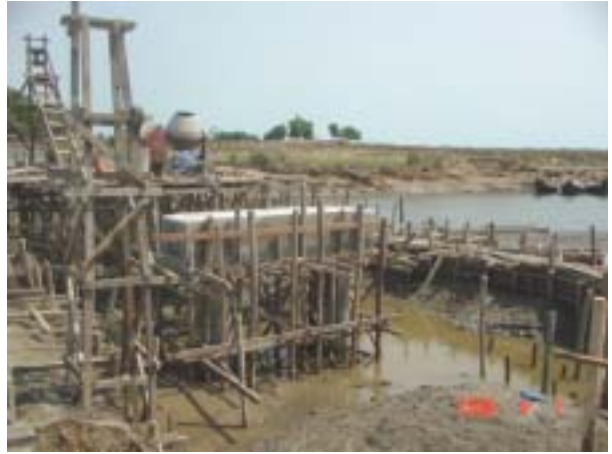
第2橋脚付近(4月1日)
