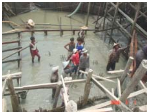
第3橋脚パイルキャップ(5月1日)
