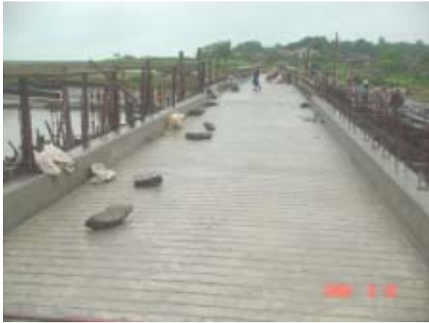
第2橋脚と第3橋脚スラブ(6月30日)
