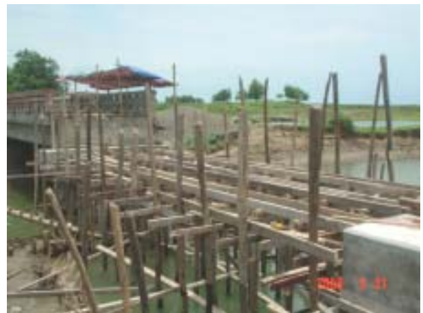
第3橋脚と第4橋脚木材型枠作業(5月31日)
