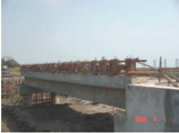
A側橋台と第1橋脚の欄干 (4月1日)
