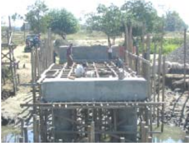
B側橋台と第4橋脚 (2月14日)
