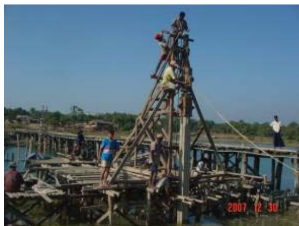
第 4 橋脚基礎杭打設作業 (12 月 30 日)
