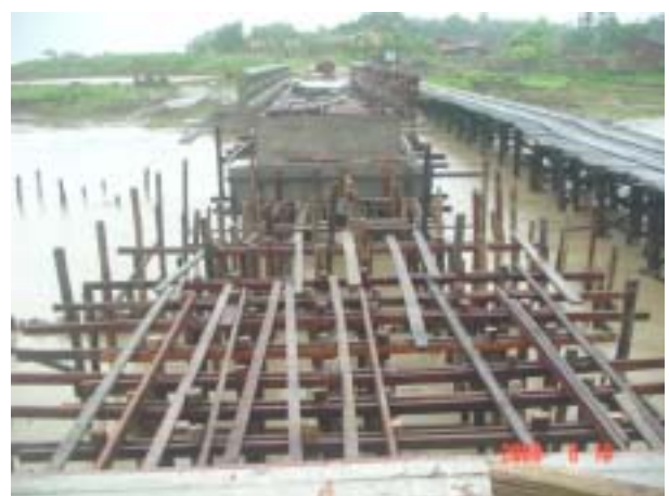
第2橋脚と第3橋脚木材型枠(6月16日)
