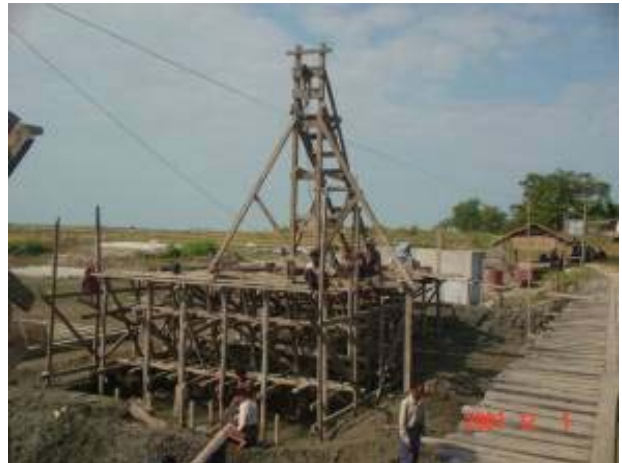
第1橋脚杭打設作業 (12月1日)
