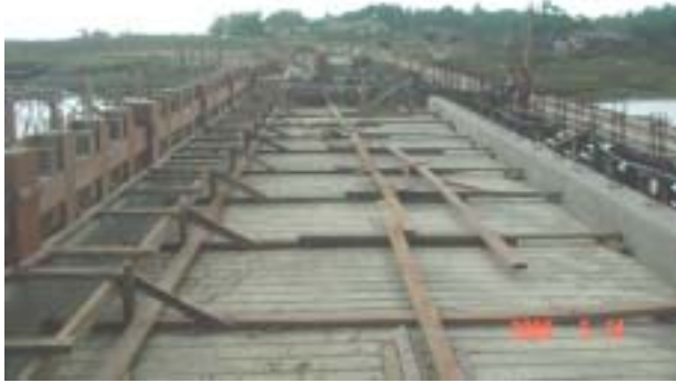
B側橋台と第4橋脚欄干進捗(5月14日)
