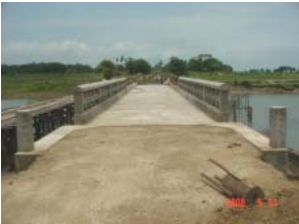
A側橋台と第1橋脚欄干(5月31日)
