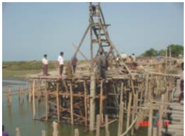
第3橋脚杭打節(4月14日)
