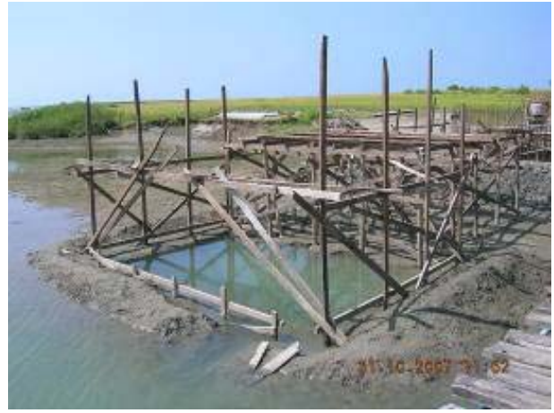
第1橋脚基礎工事 (10月31日)
