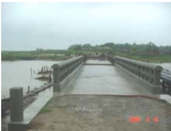
第3橋脚とB側橋台スラブ(6月16日)
