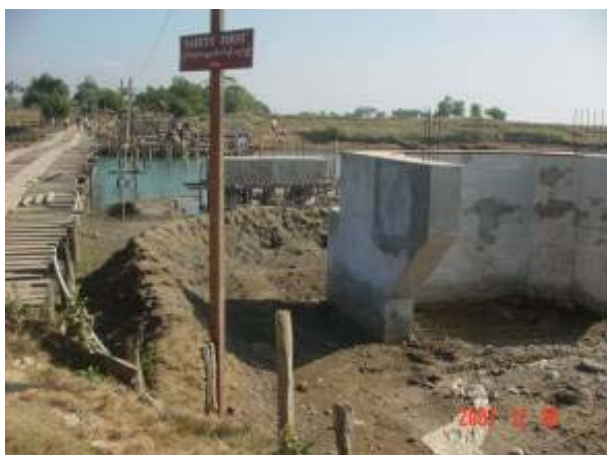
A 側橋台と第 1 橋脚 (12 月 30 日)
