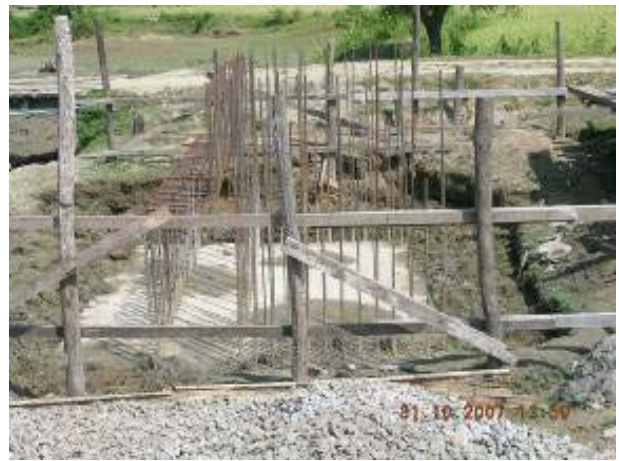
B側橋台B側基礎工事 (10月31日)
