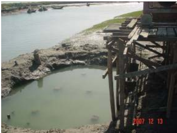
第1橋脚基礎杭設置後 (12月13日)
