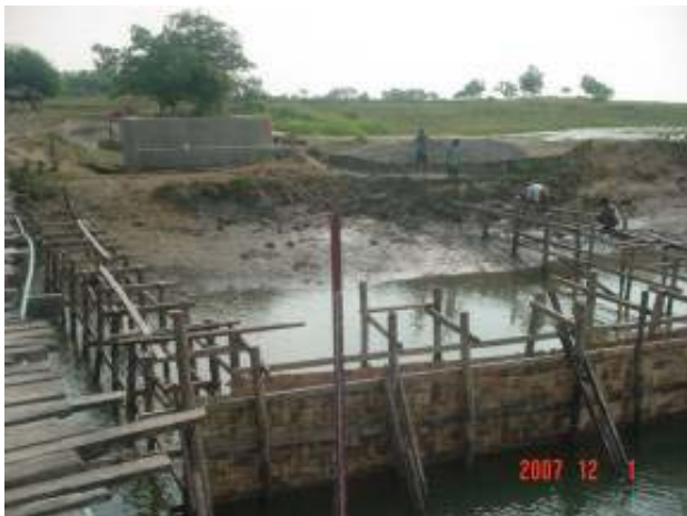
第4橋脚囲い堰とB側橋台 (12月1日)
