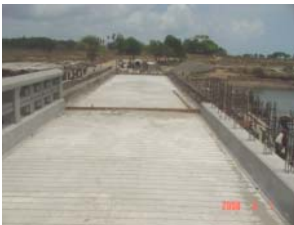
A側橋台と第1橋脚スラブ(5月1日)
