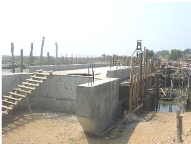
B側橋台と第4橋脚スラブ (3月15日)
