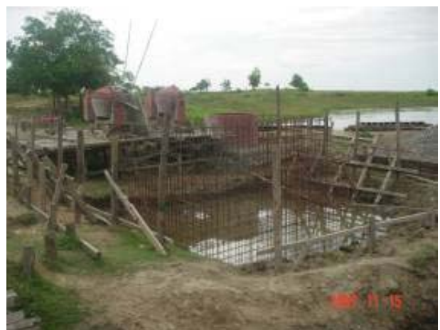
B側橋台付近(11月15日)
