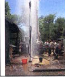
エアークンプレッサーにて 目戸孔洗浄
