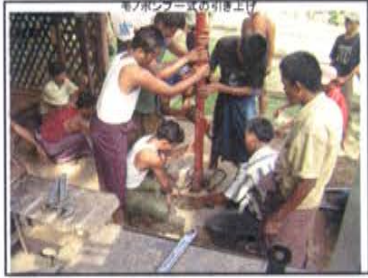
モーターヘッドの引き上げ
