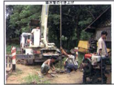
取水管の引き上げ
