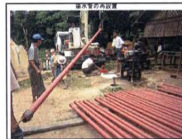
取水管の高設置
