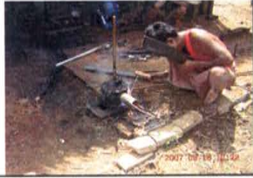
モノポンプヘッドの再設置
