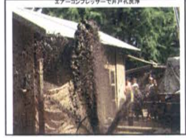
エアークンプレッサーで井戸孔洗浄
