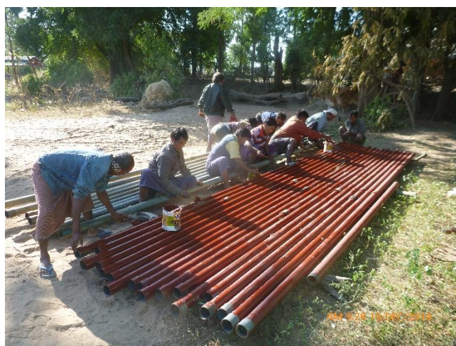
オシマウ村 揚水管に弁柄塗布作業（12月）
