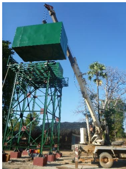
テルピンサカン村 高架型貯水タンクの建設（12月）
