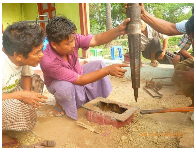
シンカ村 井戸修繕作業（フィッシング）（8月）
