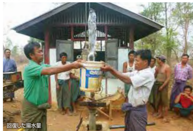
井戸孔をエアコンプレッサーを使って洗浄
