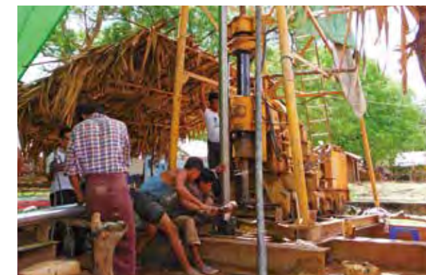
バダウゴン村の新規井戸掘削
