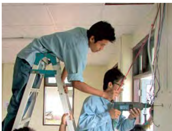
校内の食堂の屋内配線をしています
