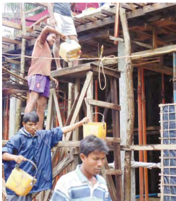
校舎は鉄筋の堅牢な造りです
