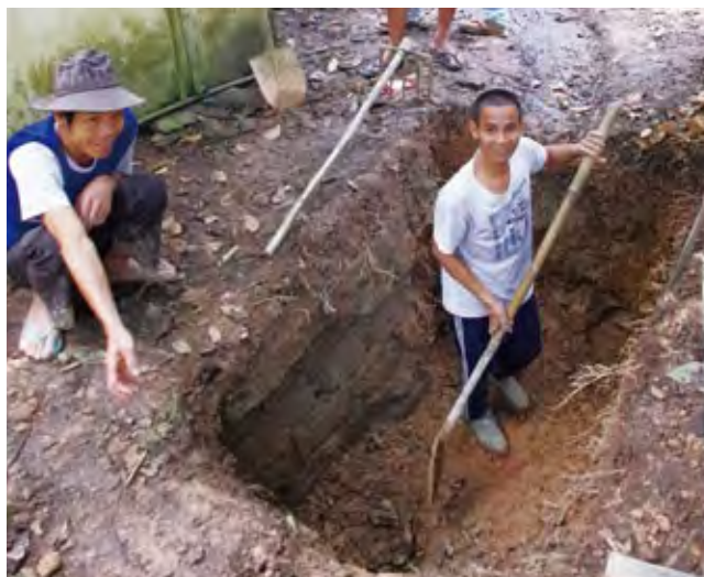
浄化槽設置の工事
