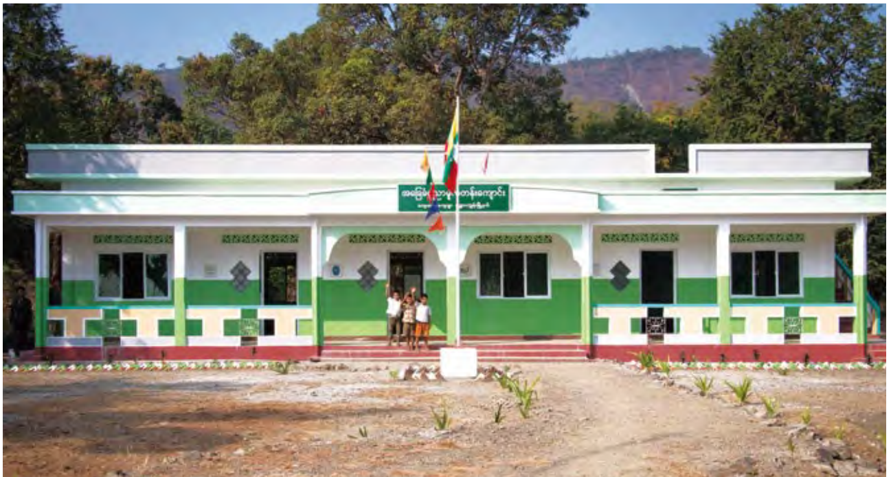
完成した校舎、このタイプの校舎では洪水時に屋上に退避できます
