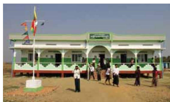
完成した新校舎
