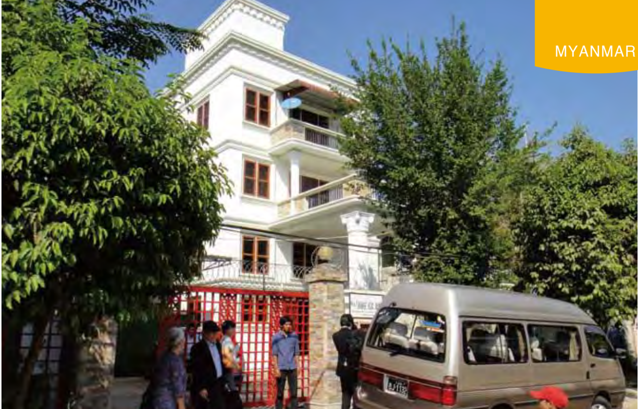
ヤンゴン事務所は4階建てです
