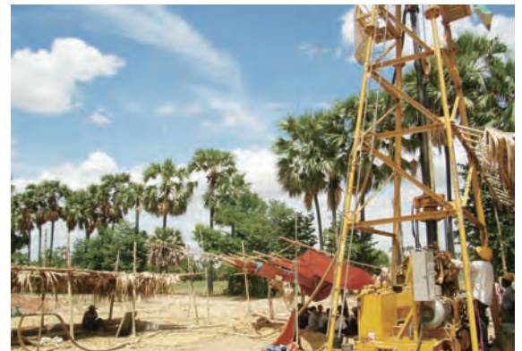
掘削機を使って、井戸を掘り進める
