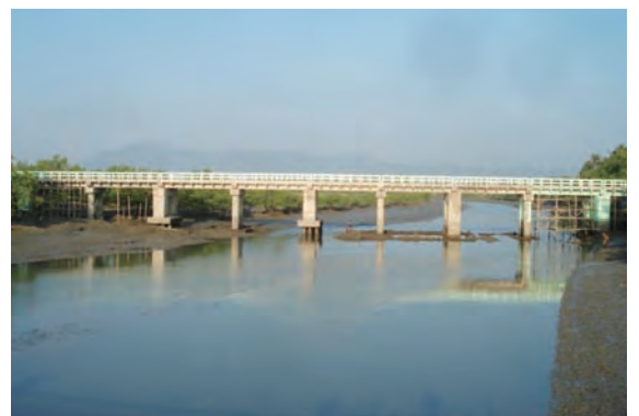
完成間近のシュウェザー橋
