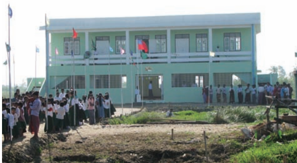
緊急時に屋上に避難できるように建設したチェッシャー小学校には、多くの人が視察に来た
