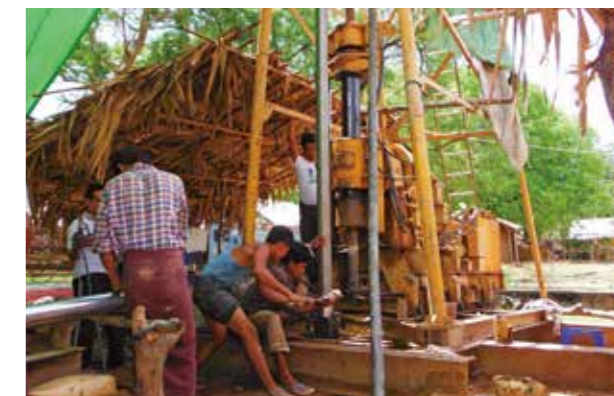
バダウゴン村の新規井戸掘削
