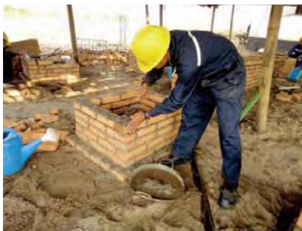
発電機建屋の柱をつくっています(石工)
