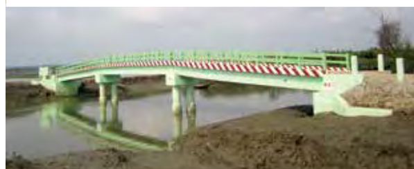
上)豪雨で倒壊した橋 下)完成した橋(レイヤーテーチャウン)
