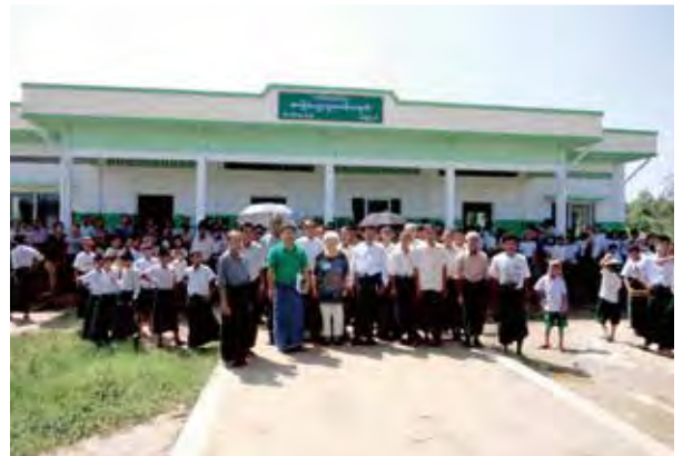
上)建設現場の様子 下)2015年に完成した校舎の前で
