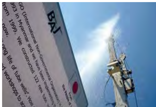
タツカン村井戸修繕にて井戸孔内洗浄中
