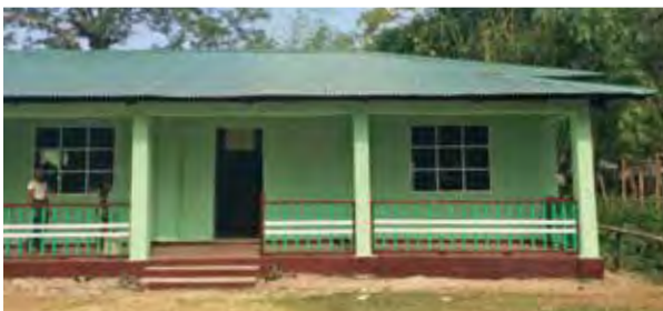
上から 1. 壁が吹き飛んだ教室 2. 豪雨で損壊した学校 3. 再建された学校
