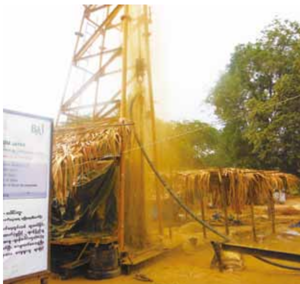
掘削後、エアコンプレッサーを使用し井戸孔内洗浄を実施します
