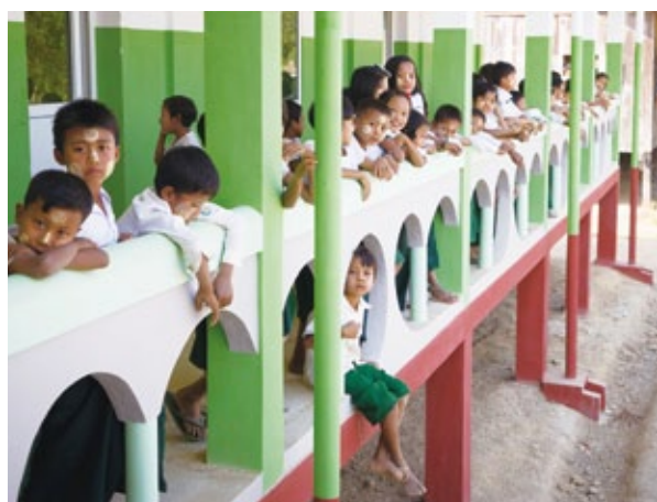
高床式の校舎は洪水の危険がある地域
