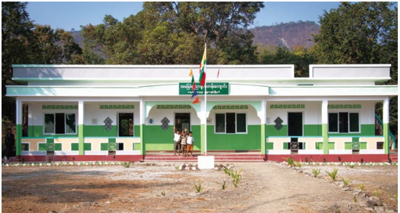
完成した校舎、このタイプの校舎では洪水時に屋上に退避できます
