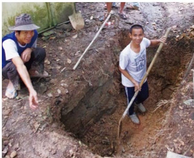
浄化槽設置の工事
