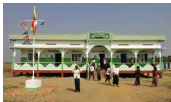
完成した新校舎
