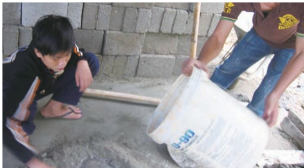
レンガとコンクリートでタンクをつくっていく
