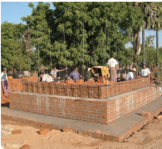
汲みあげた水を溜めるタンクの建設
