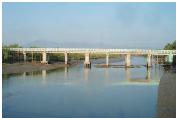
完成間近のシュウェザー橋
