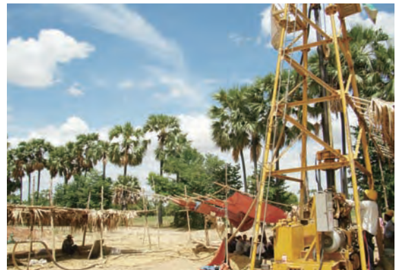
掘削機を使って、井戸を掘り進める
