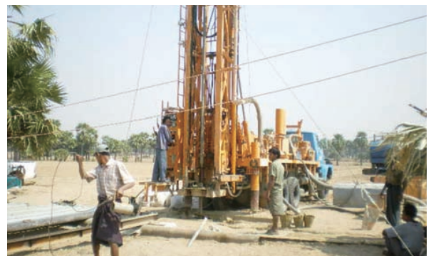
技術協力プロジェクトでの井戸掘削トレーニングの様子
